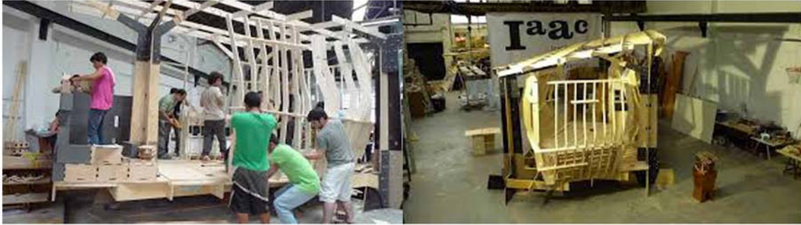
Imagen 5: Rancho virtual. A la izquierda el proceso de autoensamblado. A la derecha, el prototipo finalizado. (Fotos del IAAC, 2010)
