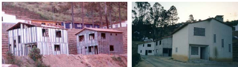
Vivienda Urb. Villa Trinidad en proceso de construcción y terminada. FOTO: IDEC/ Sipromat (12)
