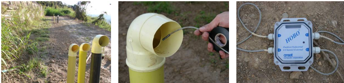
Figura 1.6.- Proceso de colocación de sensores.
