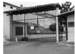
Foto 07. Urb. Mirabel Fuente propia.
