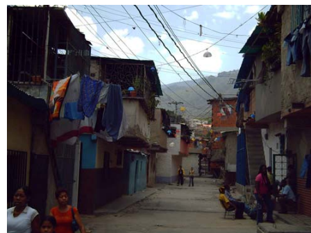
Imagen N°1: Barrio Lazareto-Caracas. Sección transversal de la Quebrada Canoa embaulada
