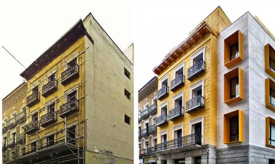
Imagen 13: Ejemplo de ampliación de edificio de viviendas en Madrid. Echavarrí, Pablo. Rehabilitación y ampliación de edificio de 20 viviendas (1.200 m<sup>2</sup>). 2005. <https://goo.gl/3hxJzX>
