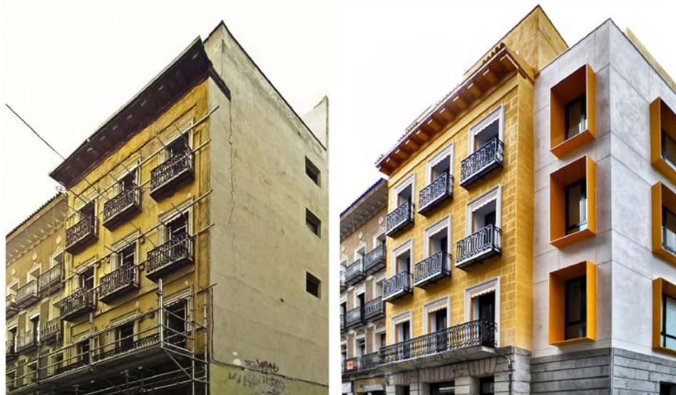
Imagen 13: Ejemplo de ampliación de edificio de viviendas en Madrid. Echavarrí, Pablo. Rehabilitación y ampliación de edificio de 20 viviendas (1.200 m 2 ). 2005. https://goo.gl/3hxJzX
