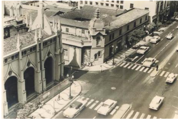
Imagen 14: La esquina de Santa Capilla en la avenida Urdaneta, con el inmueble de La Guipuzcoana, ampliado y convertido en oficina del Telégrafo, luego demolido para dar paso a la plaza hundida Andrés Eloy Blanco (Archivo de Fotografía de la Biblioteca Nacional).
