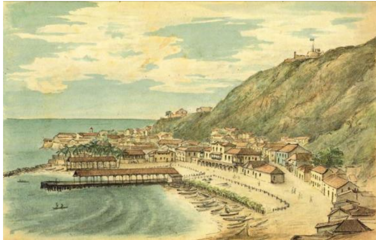
Imagen 6: La Guaira en 1866, vista desde el oeste con el muelle y tajamar realizado por el ingeniero Thomas Walter Ustick en 1845 (Geldner, 1913, p. 79).
