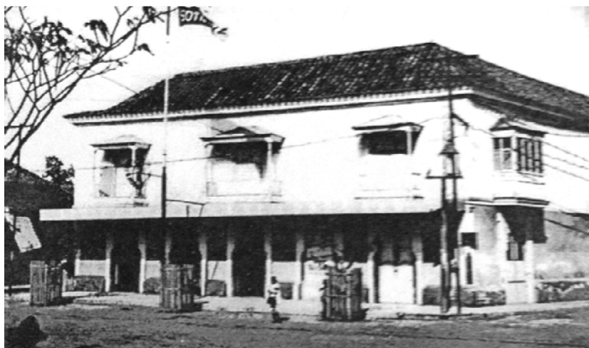
Imagen 4: Vista del Hotel Italia. (Plumacher, 2003)
