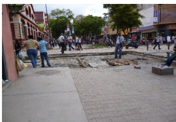
Figura 1. Reparación aceras y calles. Bulevar de Catia, agosto 2012.
