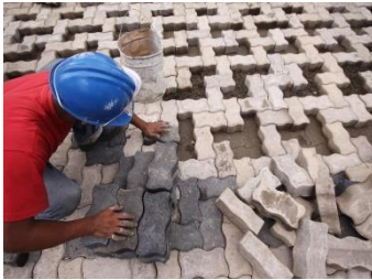
Figura 4. Colocación de adoquines. Bulevar de Sabana Grande.
