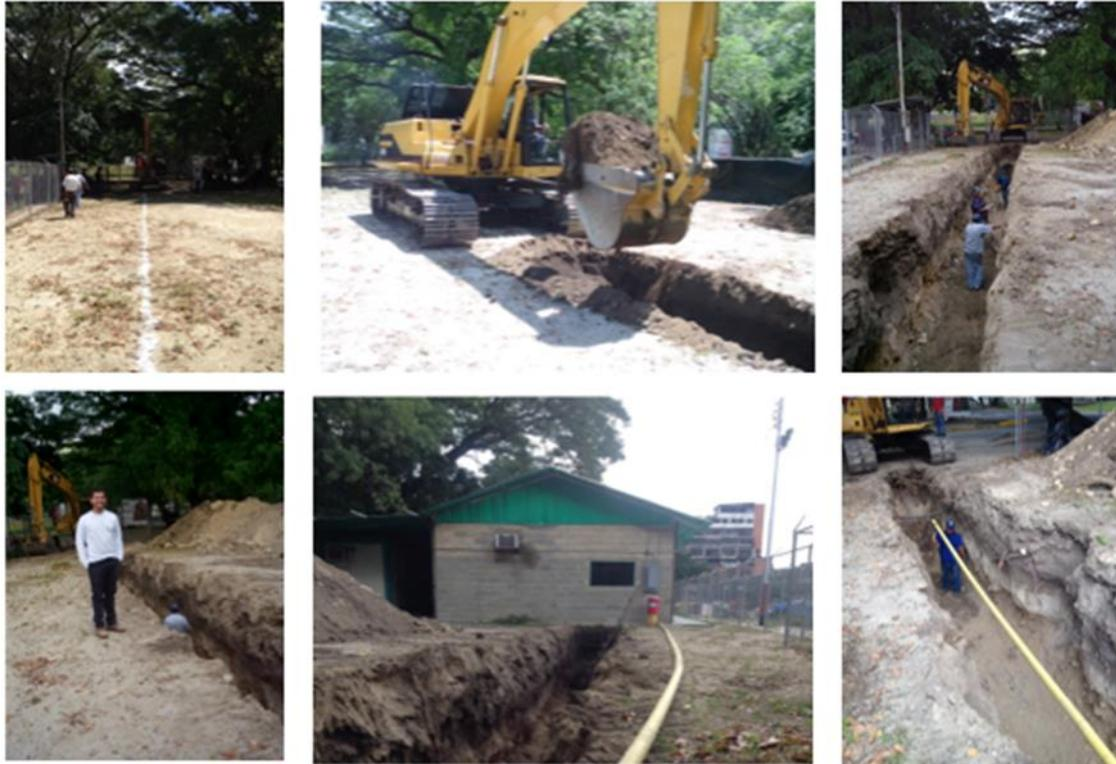
Figura 4. Realización de la zanja y colocación de los tubos.
