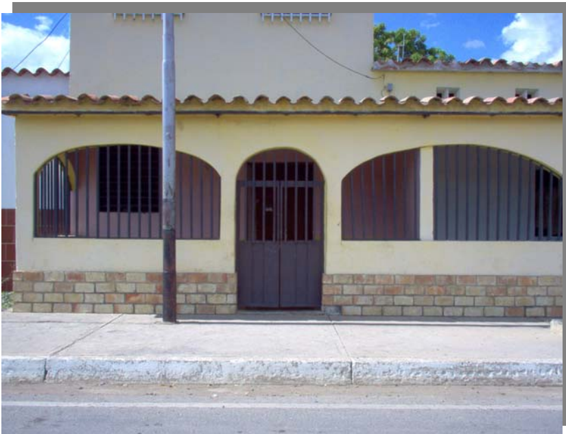
FOTO N° 1: Vista fachada principal Casa Sra. María López
