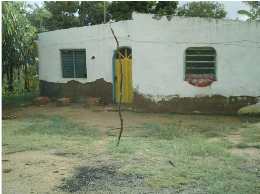
FOTO N° 2: Vista fachada principal vivienda Sra. Xiomara Benítez
