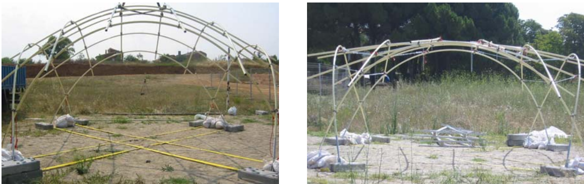
Fig. N° 23: Pérdida de la geometría Fuente: Elaboración propia
