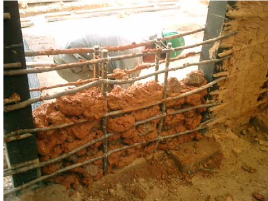
Figura 13: Relleno de piedra de ojo + barro + cal Casa Natal R Urdaneta- Cañada, Edo Zulia Fuente: Arquiluz (2007)
