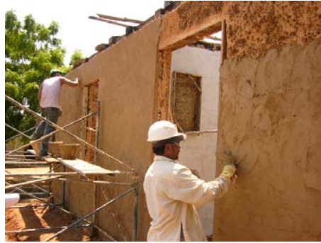
Figura 14: Aplicando el friso final sobre friso base Casa Natal R Urdaneta-Cañada, Edo Zulia Fuente: Arquiluz (2007)
