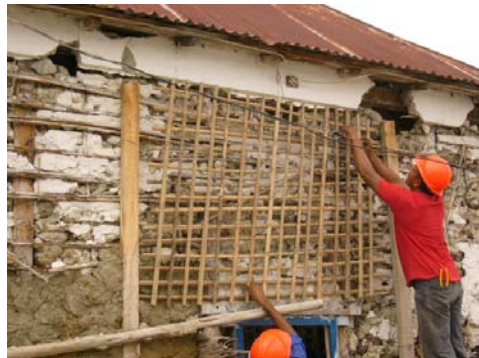
Figura 11: Retícula de varas sobre muro existente Capilla San Antonio, Edo. Zulia Fuente: Arquiluz, 2007
