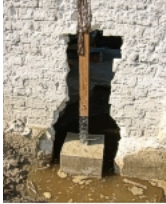
Figura 7: Horcón dentro de base de concreto Capilla San Antonio, Edo. Zulia Fuente: Arquiluz (2007)
