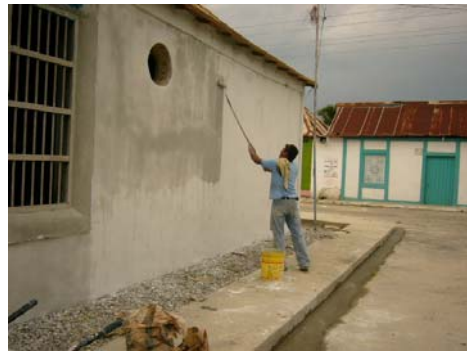
Figura 14: Aplicación pintura de caucho de tercera Capilla San Antonio, Edo Zulia Fuente: Arquiluz (2007)
