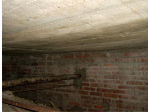
Foto 5. Losas macizas de concreto armado, como entrepiso del coro.
