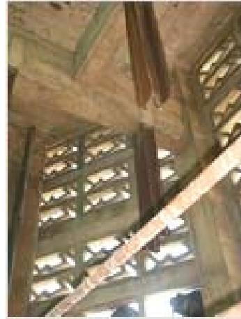
Foto 22. Vista de la cubierta y cerramientos de la torre.
