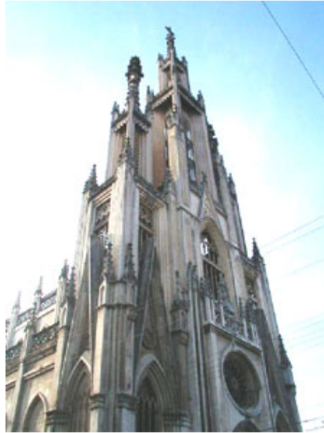
Foto 1. Vista de la fachada principal de la Iglesia San José.
