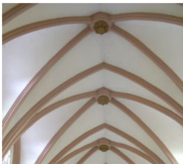
Foto 6. Vista interior de la cubierta en la nave central.
