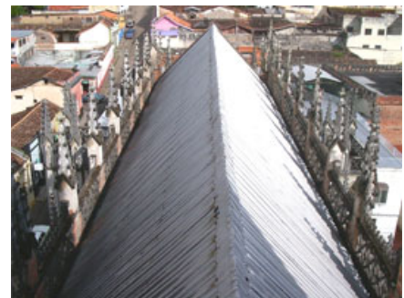
Foto 8. Cubierta inclinada a dos aguas en la nave central.
