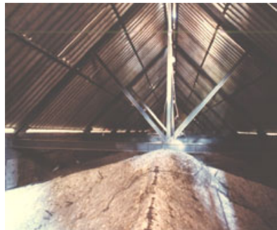
Foto 7. Soportes metálicos conformando la doble cubierta.
