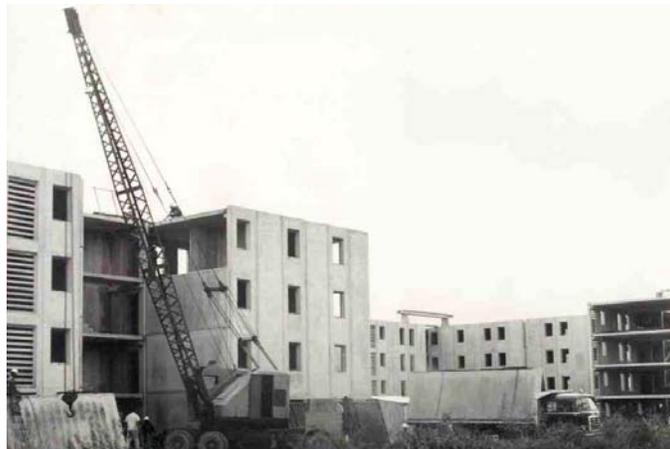
**Figura 1** Proceso de construcción de viviendas multifamiliares Sistema A-4
