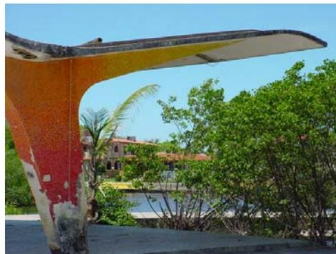
Figura 16: detalle del revestimiento con azulejos en la "Pergolita", 2003.
