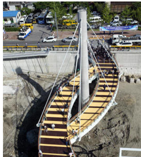
Img.35. Puente peatonal en Seúl. Fuente: www.skyscrapercity.com
