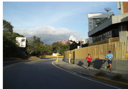
Imq.25. Infraestructura para el peatón.
