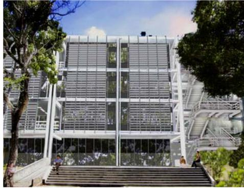
Figura 8. Fachada Propuesta. Sistema de Protección Solar
