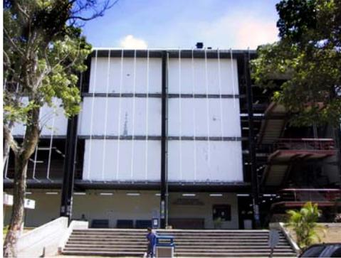
Figura 6. Fachada Sur. Vista del cerramiento externo de la edificación con láminas de acero galvanizado
